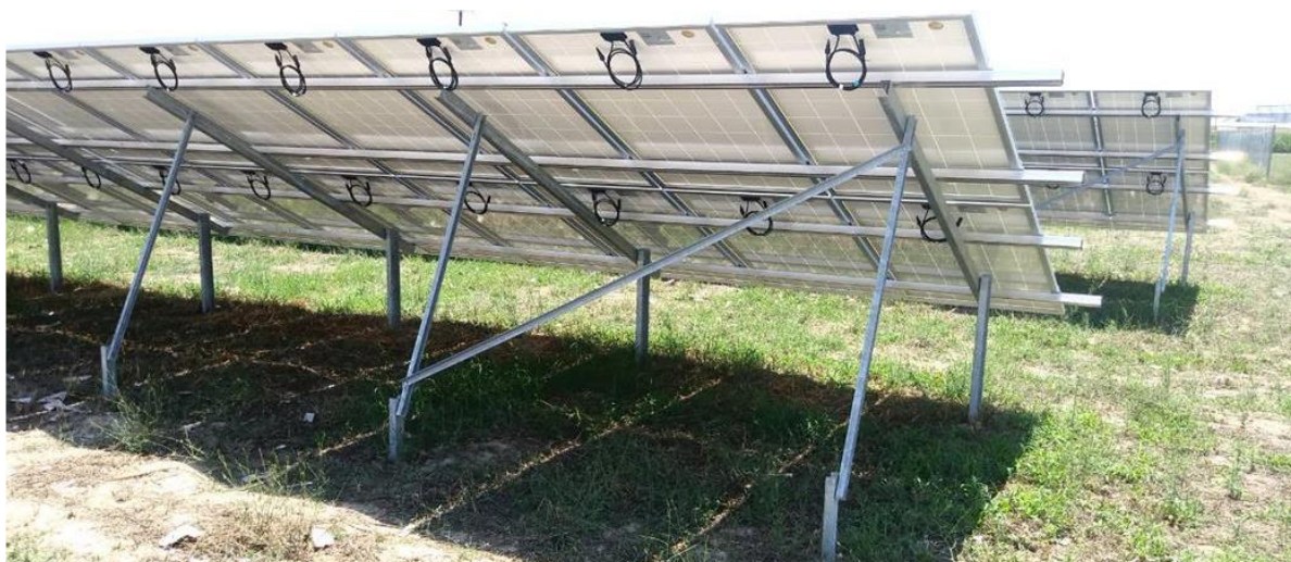
Slika 4 Način montaže noseće konstrukcije
