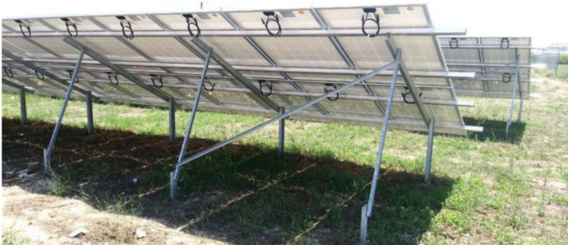
Slika 4 Način montaže noseće konstrukcije
