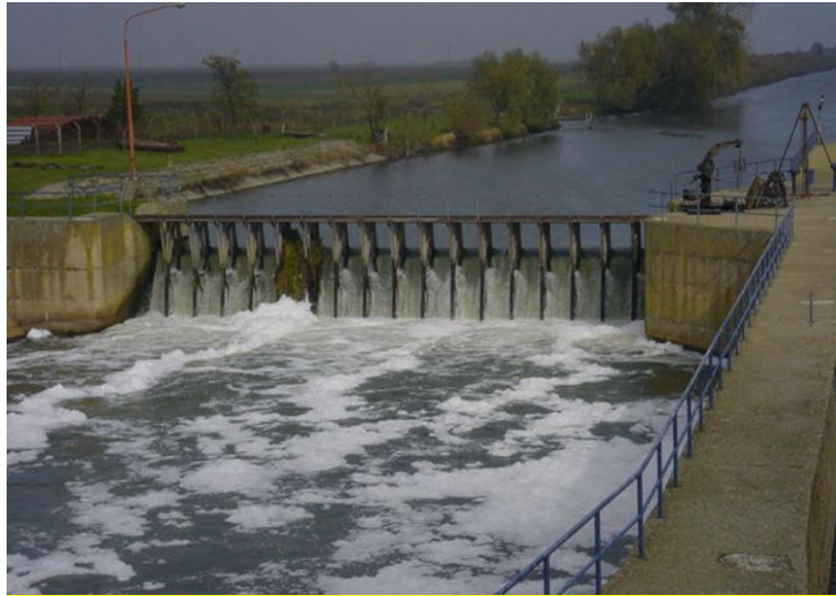
Слика 10. Хидрокомплекс Клек
